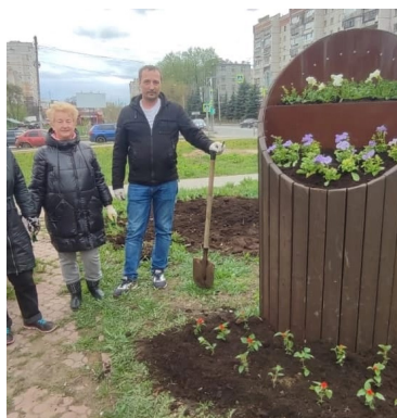
Работы по организации клумбы в сквере на ул. Ивана Сусанина
