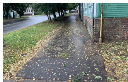
Асфальтирование тротуара на ул. Свердлова , в районе д. 48
